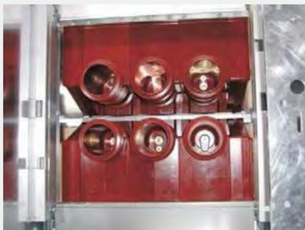
Рис. 29. Отсек выкатного элемента
