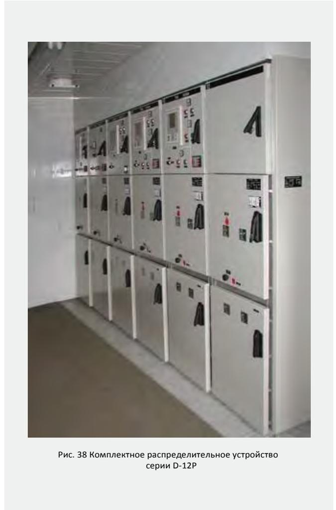
Рис. 38 Комплектное распределительное устройство серии D-12P
