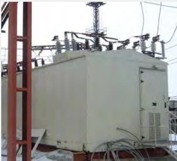
Рис. 20. Установка модуля на низкий фундамент
