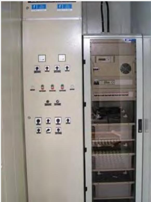
Рис. 53. Распределительное устройство собственных нужд (РУСН) напряжением 0,4 кВ (слева); шкаф оперативного тока (ШОТ) с комплектом аккумуляторных батарей (справа)
