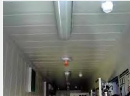
Рис. 54 Основное и аварийное освещение
