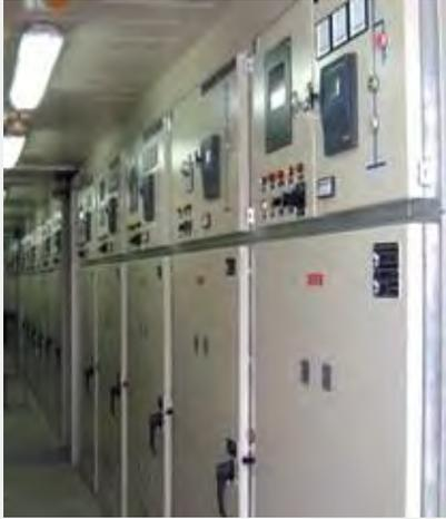
Рис. 25 Комплектное распределительное устройство серии D-40P
