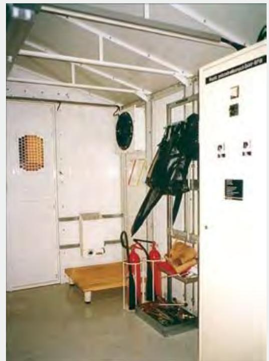
Рис. 61. Стойка средств защиты с установленными защитными средствами
