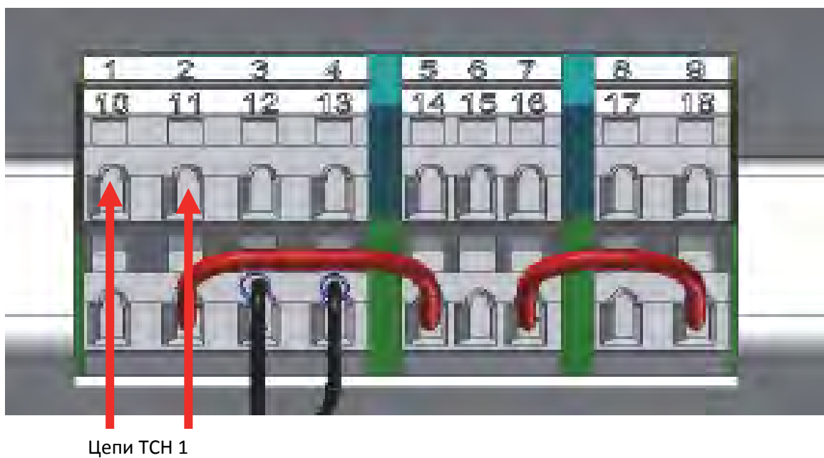
Рис. 8.13. Подключение оперативного питания от одного ТСН
