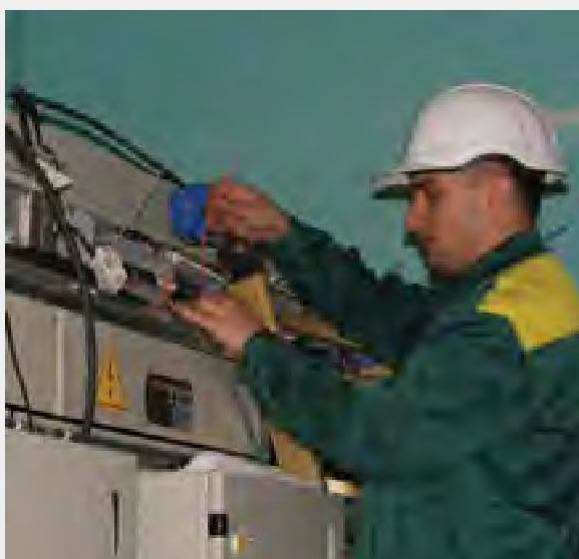
Рис. 5.13. Прокладка транзитных цепей
