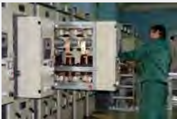
Рис. 5.3. «Ремонтное» положение моноблока
