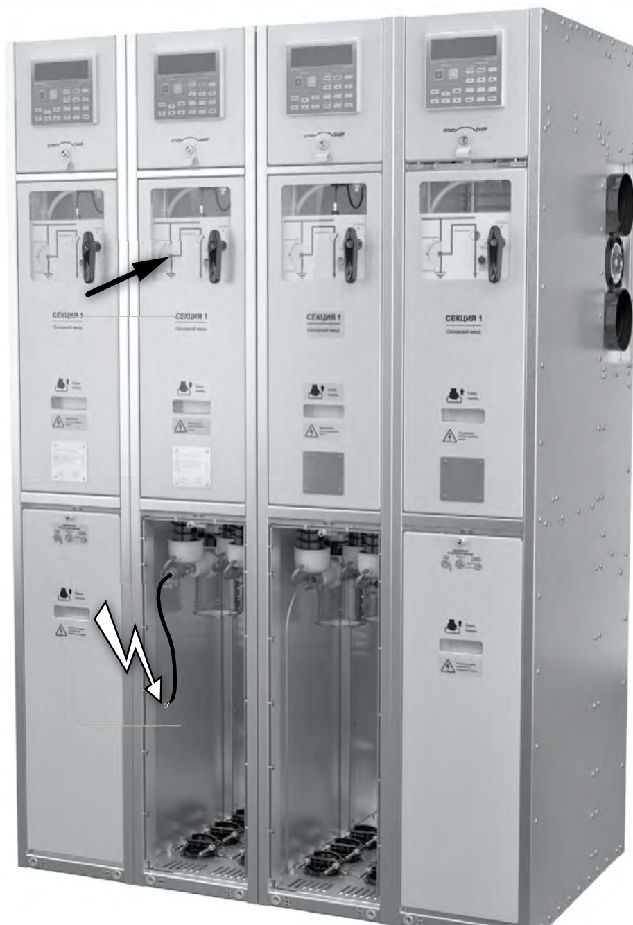
Рис. 30. Проверка воздушного промежутка разъединителя
