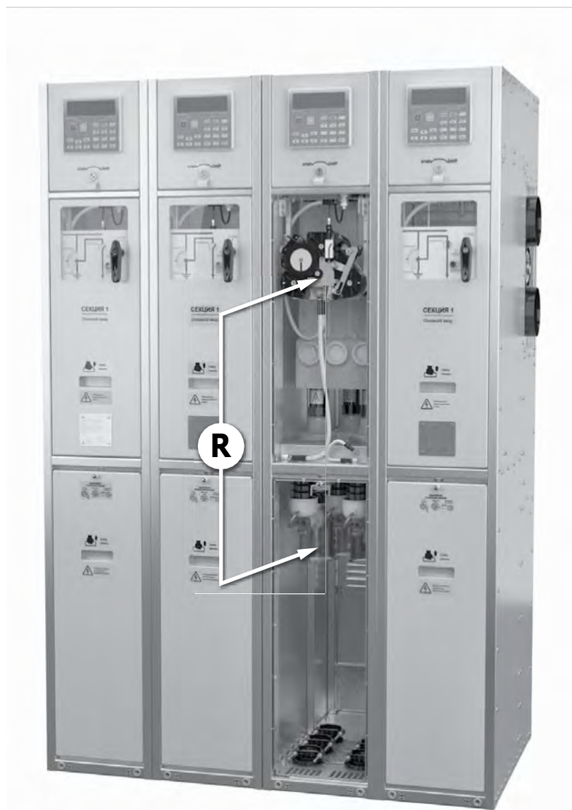
Рис. 26. Измерение переходного сопротивления между плитой заземления разъединителя и нижними выводами КДТН шкафа
