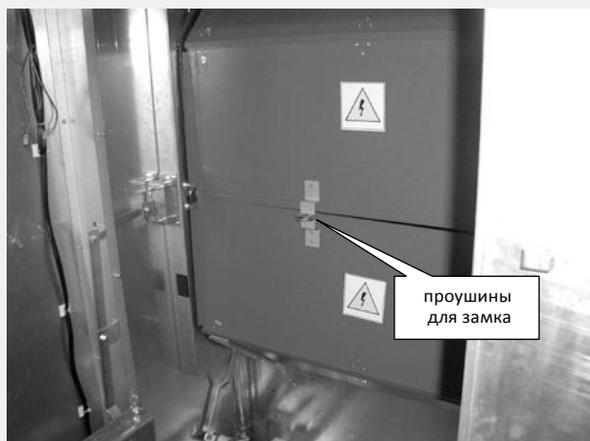
Рис. 8. Отсек выкатного элемента при закрытых шторках
