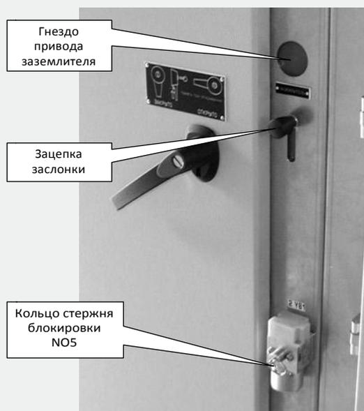
Рис. 11. Электромагнитная блокировка NO5
