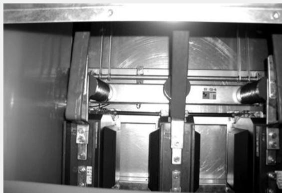
Рис. 26. Вид отсека сборных шин после демонтажа ревизионной панели
