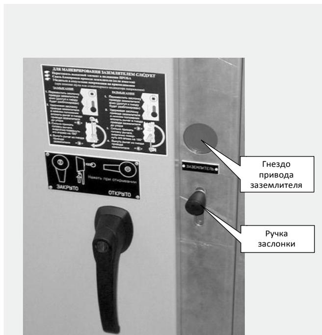
Рис. 21. Органы доступа к приводу заземлителя
