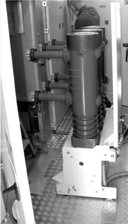
Рис. 19. ВЭ в ремонтном положении
