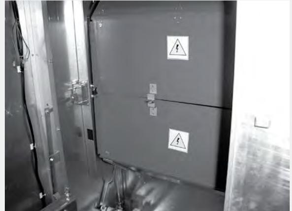
Рис. 3. Отсек выкатного элемента при закрытом шторочном механизме
