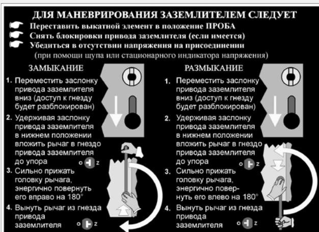
Рис. 20. Информационная табличка об оперировании заземлителем
