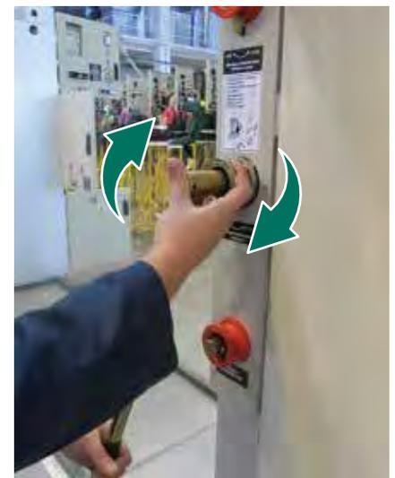
Рис. 2.16. Включение выключателя нагрузки
