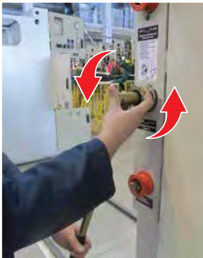
Рис. 2.17. Отключение выключателя нагрузки
