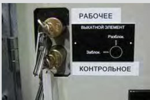
Рис. 1.37. Замковая блокировка перемещения КВЭ.
