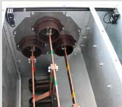
Рис.1.48. Концевые выключатели клапанов сброса давления
