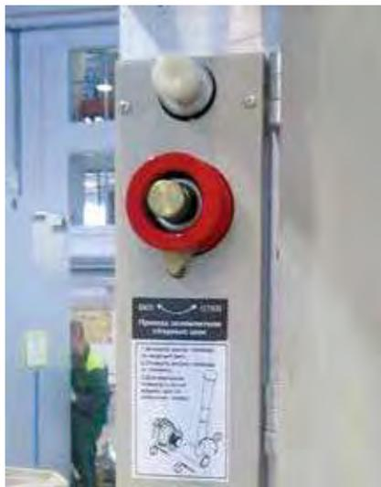
Рис. 2.18. Гнездо привода заземлителя СШ
