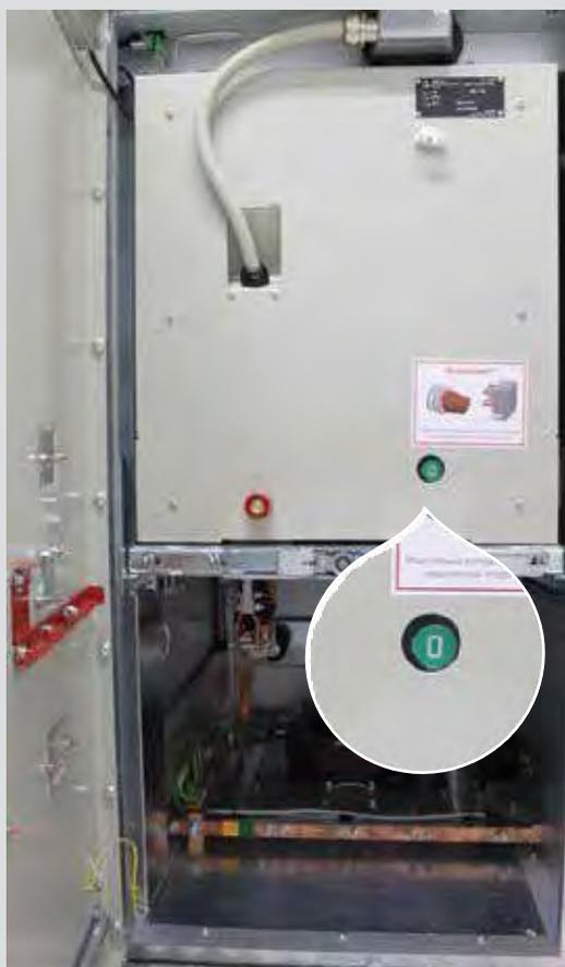
Рис.2.13. Механический индикатор состояния силового выключателя
