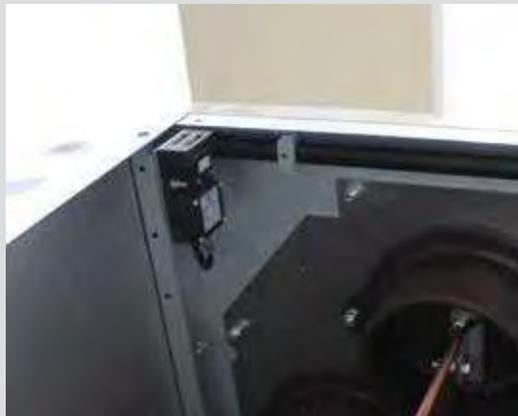
Рис. 1.27. Концевой выключатель в отсеке сборных шин
