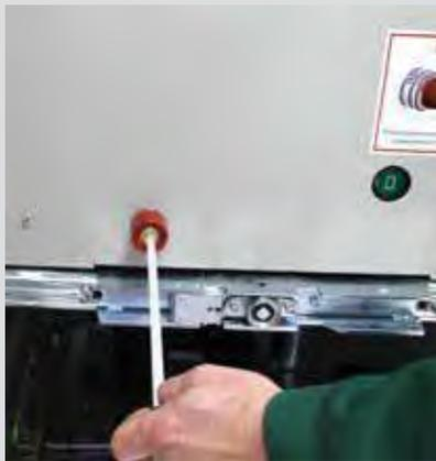
Рис. 2.29. Приемная кнопка ручного отключения выключателя ISM15\_LD (вид с открытой дверью отсека)
