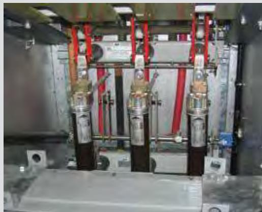
Рис. 1.31. Выключатель нагрузки в шкафу ТСН
