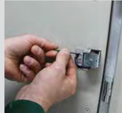
Рис. 2.38. Демонтаж блокировки Y81
