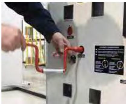
Рис. 2.4. Фиксация ручки перемещения КВЭ
