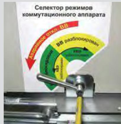
Рис. 2.30. Аварийное отключение выключателя ISM15\_Shell с фасада шкафа (вид с открытой дверью отсека)
