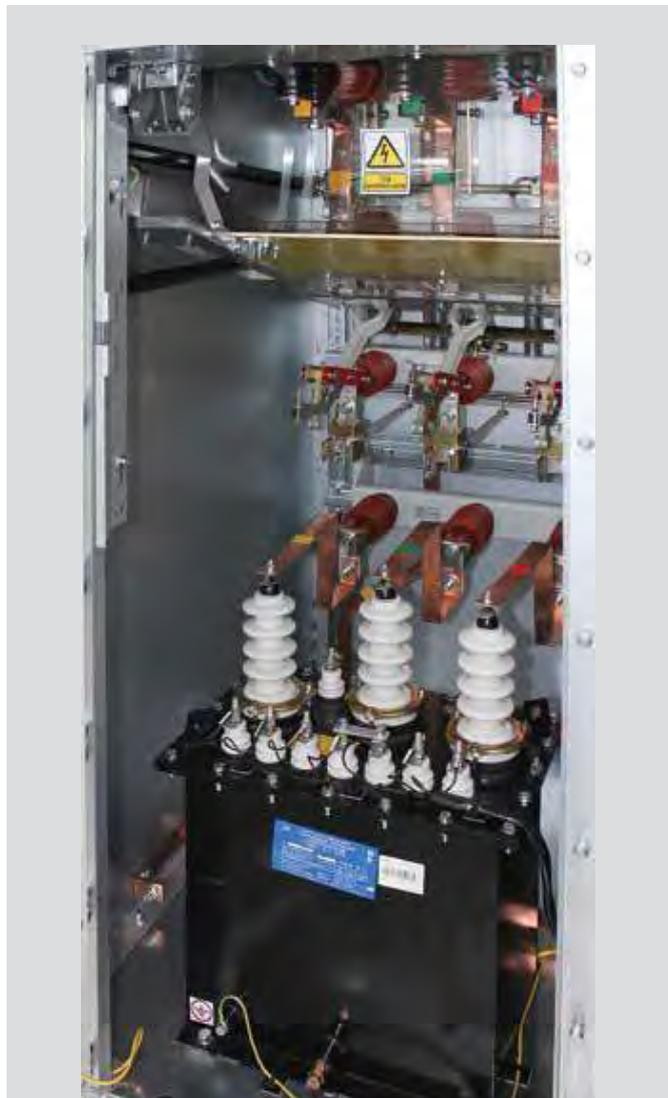
Рис. 1.30. Шкаф с измерительным ТН типа НАМИТ
