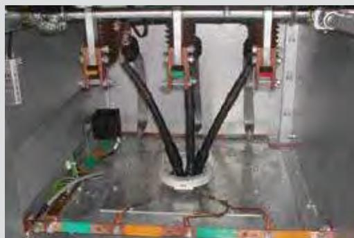
Рис.1.8. Зона присоединений высоковольтного отсека
