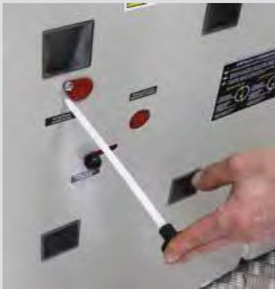
Рис. 2.28. Аварийное отключение выключателя ISM15\_LD
