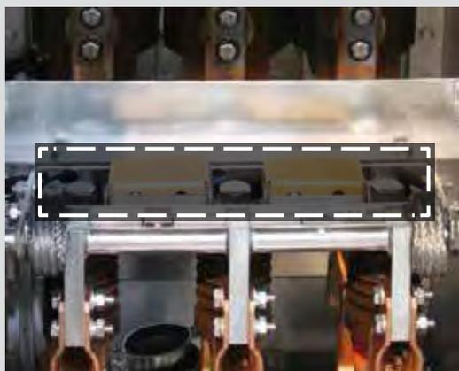
Рис. 1.29. Концевые выключатели положения заземлителя
