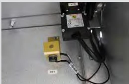
Рис. 1.53. Двухступенчатая дуговая защита
