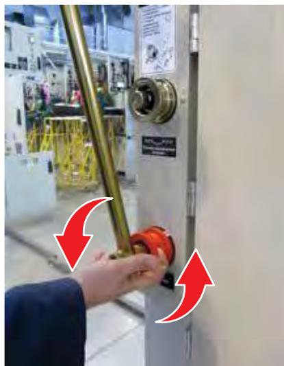
Рис. 2.15. Отключение заземлителя
