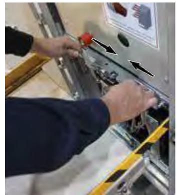
Рис. 2.23. Расфиксация КВЭ от корпуса шкафа
