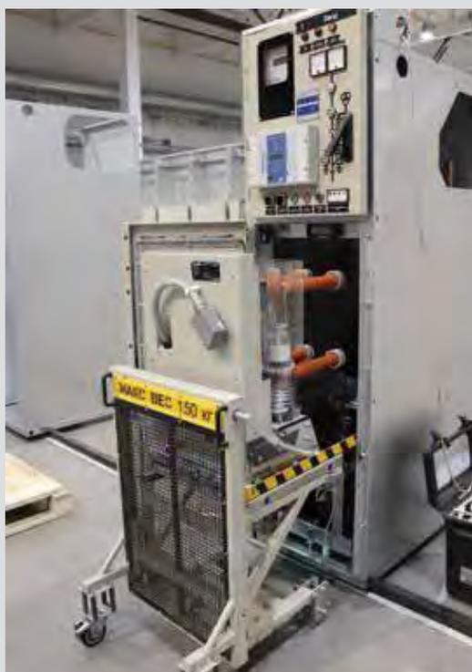
Рис. 1.23 КВЭ в ремонтном положении
