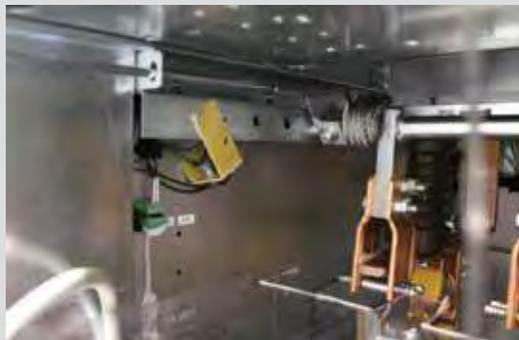
Рис. 1.50. Размещение фототиристора в зоне присоединений
