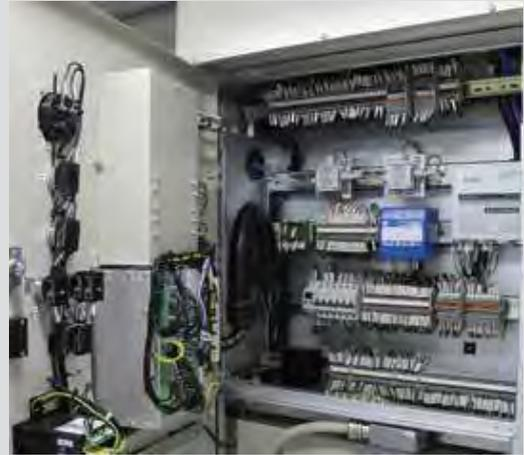
Рис. 1.10. Релейный отсек (вид с открытой дверью)
