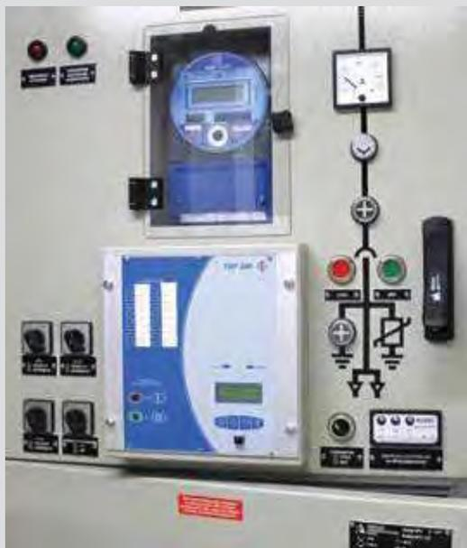
Рис.2.12. Фасад релейного отсека с органами местного управления
