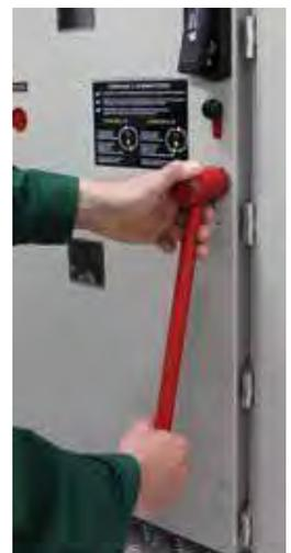
Рис. 2.11. Заземлитель присоединения включен
