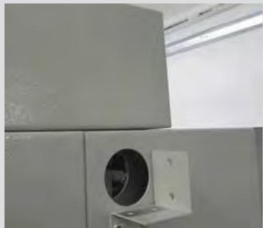
Рис. 1.12. Отверстия для прокладки межсекционных связей
