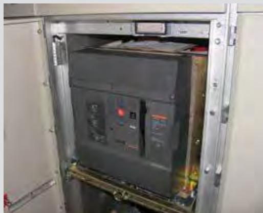
Рис. 2.32. КВЭ с выключателем Evolis
