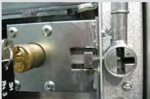
Рис. 1.38. Блокировка оперирования заземлителем
