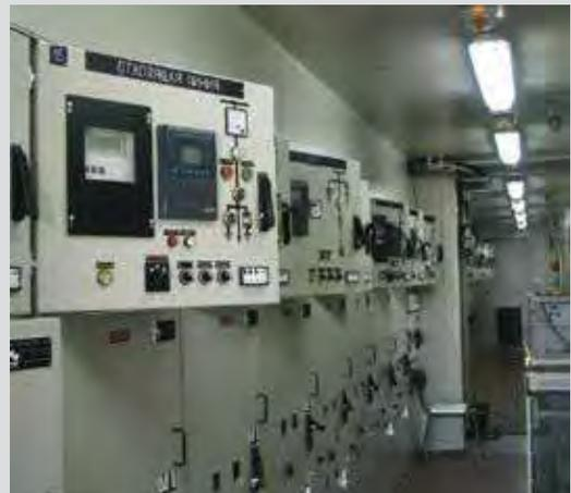
Рис. 1.11. Релейный отсек (вид с фасада)
