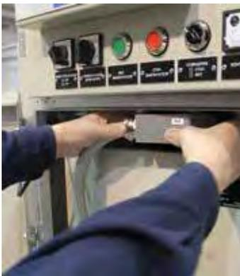
Рис. 2.20. Отключение разъема вспомогательных цепей
