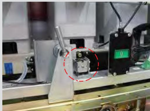
Рис. 2.43. Расположение блокировки Y0 в шкафу с выключателем ВВ/TEL типа ISM15\_Shell
