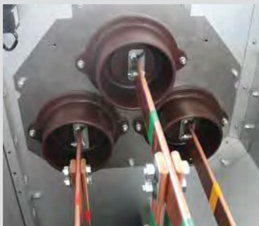
Рис. 1.4. Проходные изоляторы в отсеке сборных шин
