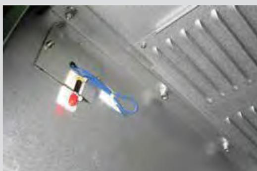
Рис. 1.52. Волоконно-оптический датчик в отсеке сборных шин
