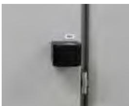
Рис. 2.6. Электромагнитная блокировка Y81
