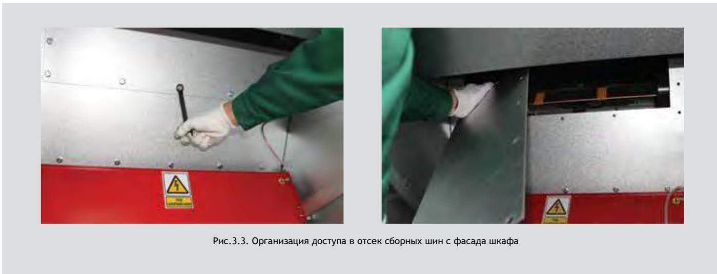
Рис.3.3. Организация доступа в отсек сборных шин с фасада шкафа
