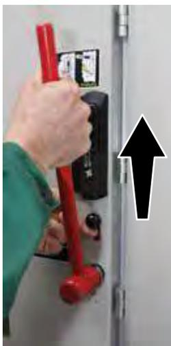
Рис. 2.8. Организация доступа к гнезду оперирования заземлителем
