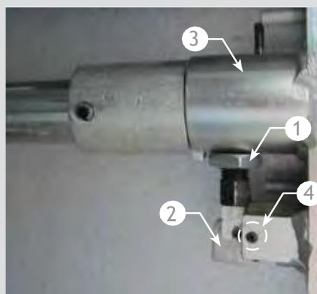
Рис. 2.33. Механизм блокировки открывания двери отсека при отключенном состоянии заземлителя
