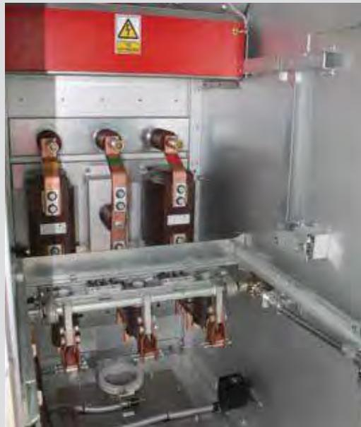
Рис.1.6. Совмещенный высоковольтный отсек
