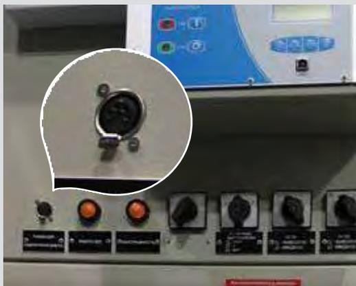
Рис. 2.31. Разъем для подключения БМВ/TEL на фасаде релейного отсека
