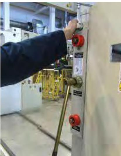
Рис. 2.14. Перемещение изоляционной плиты
