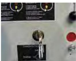
Рис. 2.7. Замковая блокировка BZ
