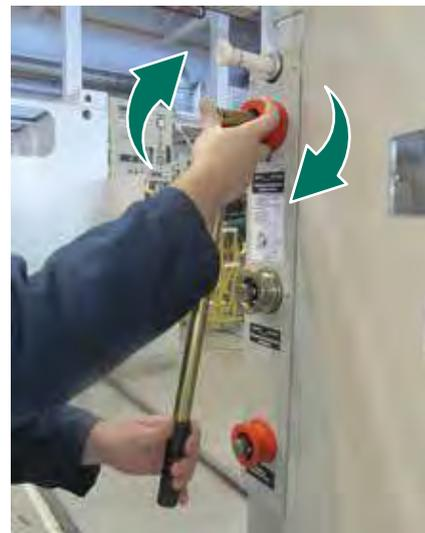
Рис. 2.19. Включение заземлителя СШ
