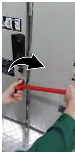
Рис. 2.10. Включение заземлителя
