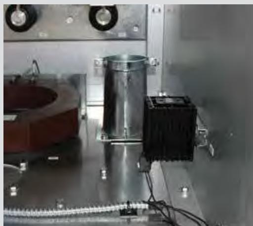
Рис. 1.56. Антиконденсатный нагревательный элемент в зоне присоединений
