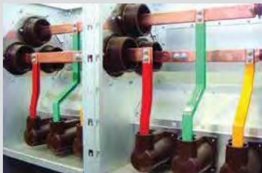
Рис. 1.3. Отсек сборных на этапе сборки шкафов КРУ
