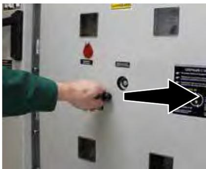
Рис. 2.3. Доступ к гнезду оперирования КВЭ
