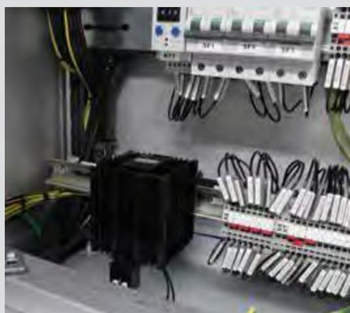
Рис. 1.55. Антиконденсатный нагревательный элемент в релейном отсеке
