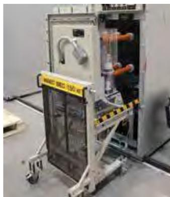
Рис. 2.26. КВЭ в ремонтном положении
