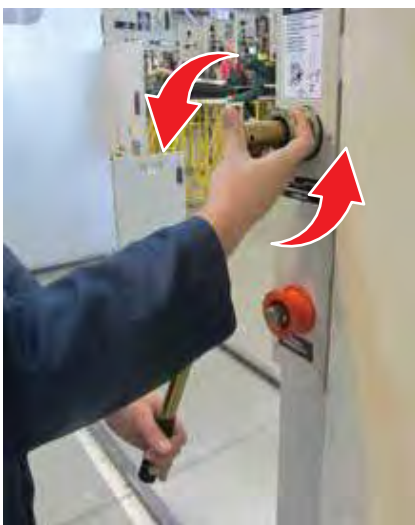
Рис. 2.16. Отключение выключателя нагрузки
