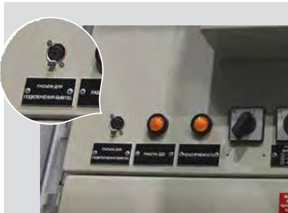
Рис. 2.26. Разъем для подключения БМВ/TEL на фасаде релейного отсека
