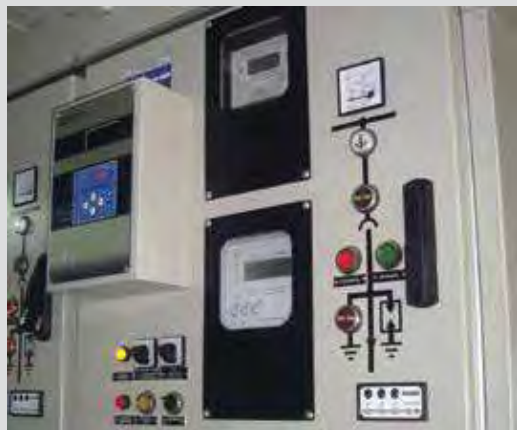
Рис. 2.12 Фасад отсека вспомогательных цепей с органами местного управления
