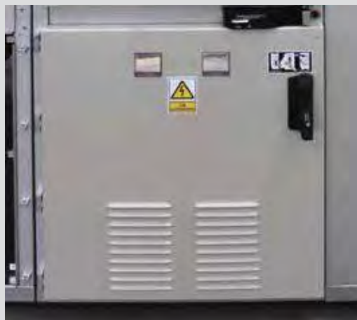
Рис. 1.58. Вентиляционные отверстия в двери отсека присоединений
