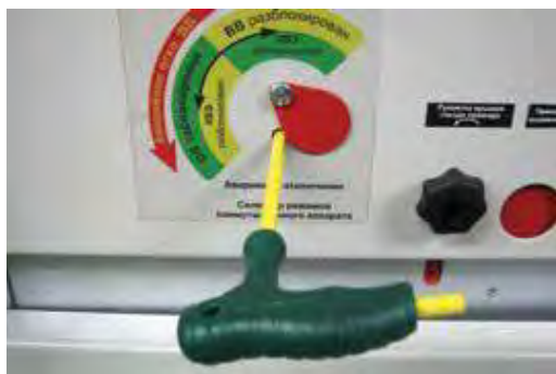
Рис. 2.3. Разблокирование перемещения КВЭ
