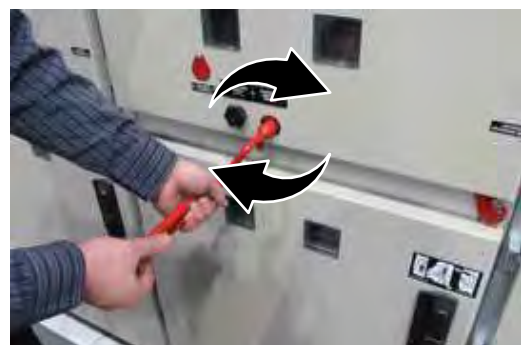
Рис. 2.6. Вращение винтовой передачи КВЭ
