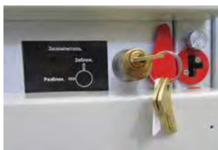
Рис. 2.8. Замковая блокировка BZ
