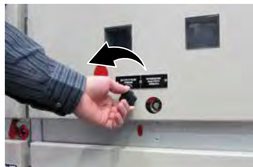
Рис. 2.4. Доступ к гнезду оперирования КВЭ
