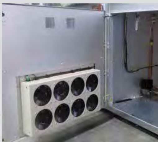
Рис. 1.59. Принудительная приточная вентиляция
