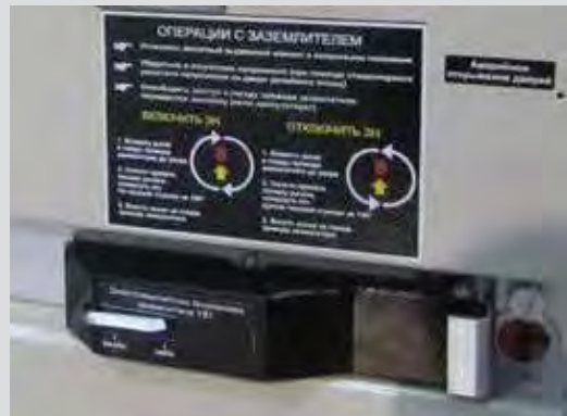
Рис. 2.35. Фиксация и сборка в отключенном положении
