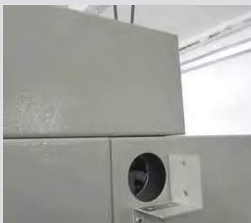
Рис. 1.16. Отверстия для прокладки межсекционных связей
