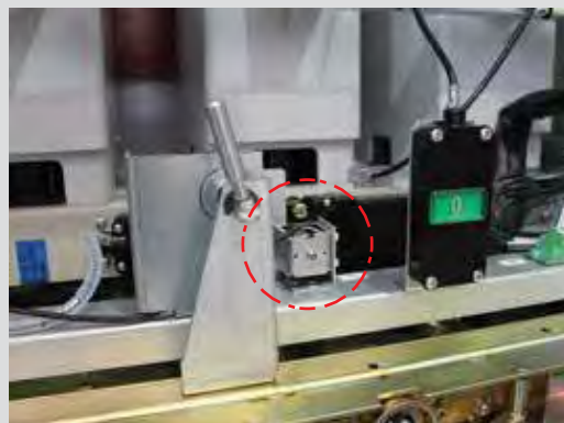
Рис. 2.40. Расположение блокировки Y0 в шкафу с выключателем ВВ/ТЕЛ типа ISM15_Shell
