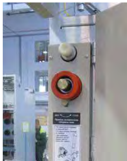
Рис. 2.17. Гнездо привода заземлителя СШ
