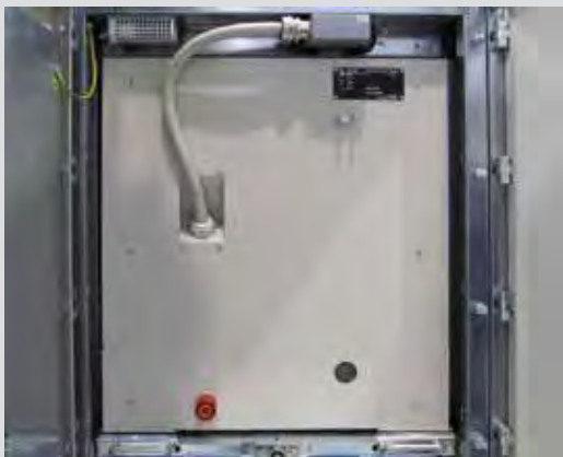
Рис. 1.27. KBЭ в контрольном положении (вид при открытой двери)
