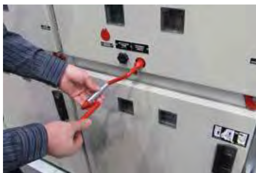
Рис. 2.5. Фиксация ручки перемещения
