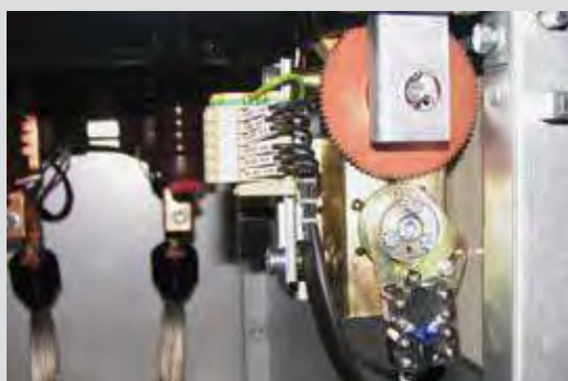
Рис.1.12. Электропривод заземлителя
