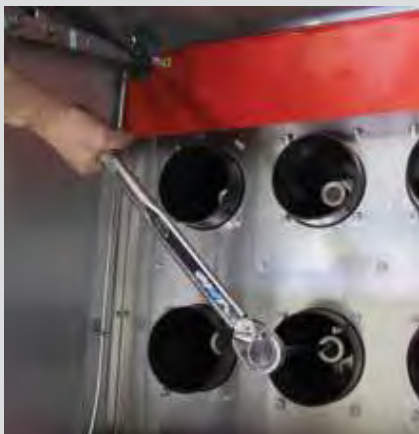
Рис. 3.7. Демонтаж контактов (пример)
