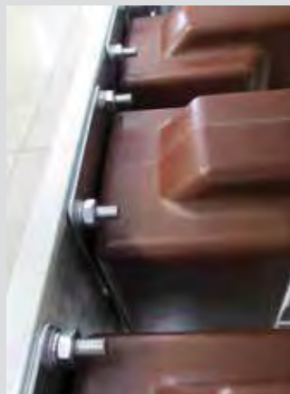
Рис. 3.8. Крепление трансформаторов тока
