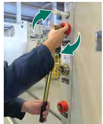
Рис. 2.18. Включение заземлителя СШ
