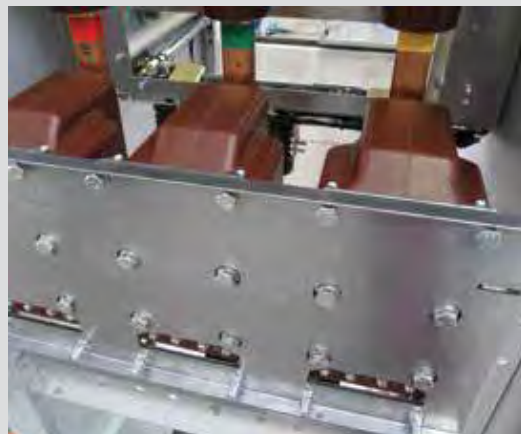
Рис. 3.8. Крепление трансформаторов тока
