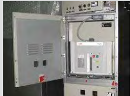
Рис. 2.27. КВЭ с выключателем VD4
