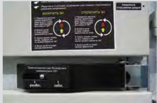
Рис. 1.40. Электромагнитная заземлителя
