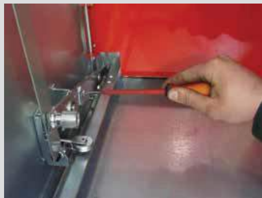
Рис. 3.6. Разблокирование нижней шторки
