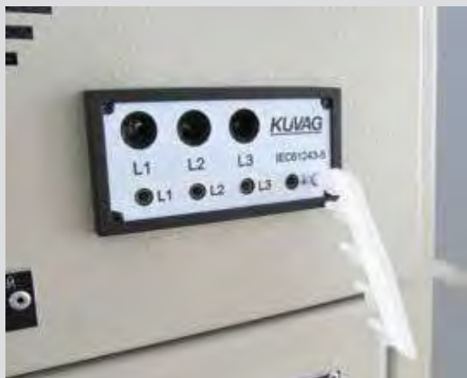
Рис. 1.30. Индикатор наличия напряжения
