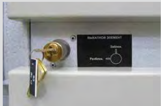
Рис. 1.41. Замковая блокировка перемещения КВЭ
