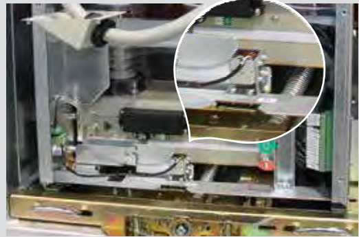
Рис. 1.39. Электромагнитная блокировка КВЭ
