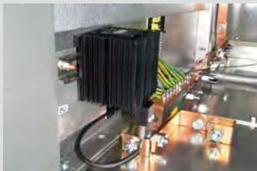
Рис. 1.62. Антиконденсатный нагревательный элемент
