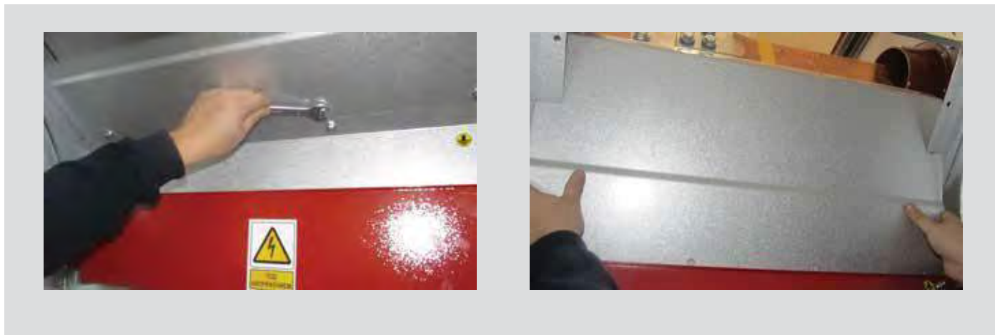
Рис. 3.4. Организация доступа в отсек сборных шин с фасада шкафа
