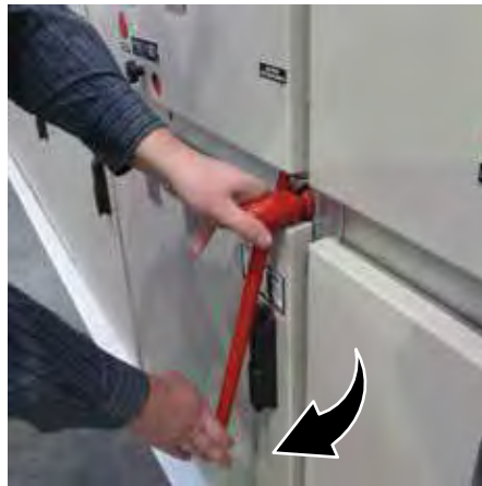
Рис. 2.10. Заземлитель присоединения включен
