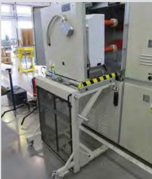
Рис. 1.28. KBЭ в ремонтном (сервисном) положении
