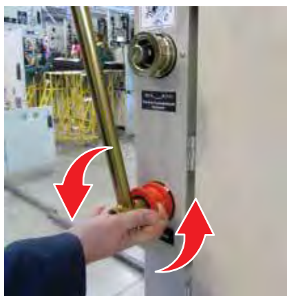
Рис. 2.14. Отключение заземлителя
