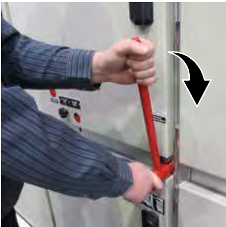
Рис. 2.9. Размещение рычага оперирования заземлителем
