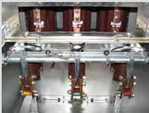
Рис. 3.5. Вид после демонтажа ревизионной панели и перегородки
