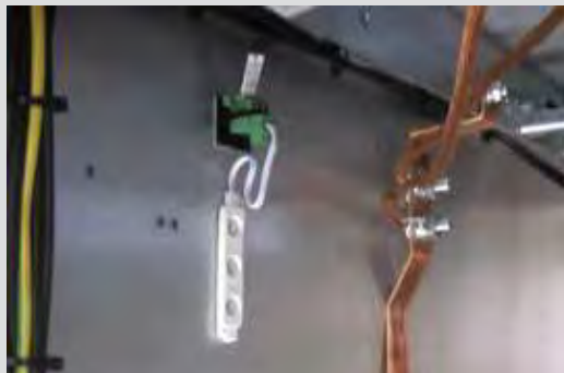
Рис. 1.61. Светодиодный модуль освещения отсека присоединений
