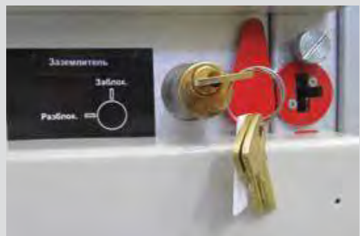
Рис. 1.42. Блокировка оперирования заземлителем
