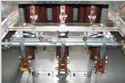
Рис.1.10. Вид отсека при демонтированных съемной перегородке и ревизионной панели
