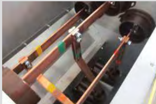
Рис. 1.7. Отсек сборных (вид сверху при снятом клапане сброса давления)
