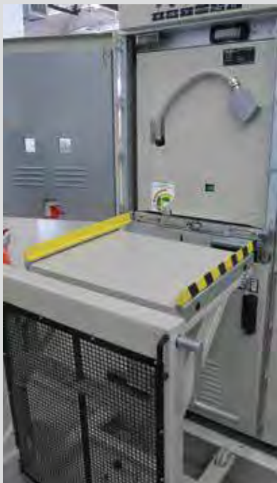
Рис. 2.19. Стыковка и фиксация инвентарной сервисной тележки
