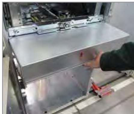
Б - Демонтаж перегородки
